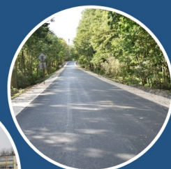
BUDOWA I MODERNIZACJA DRÓG POWIATOWYCH
